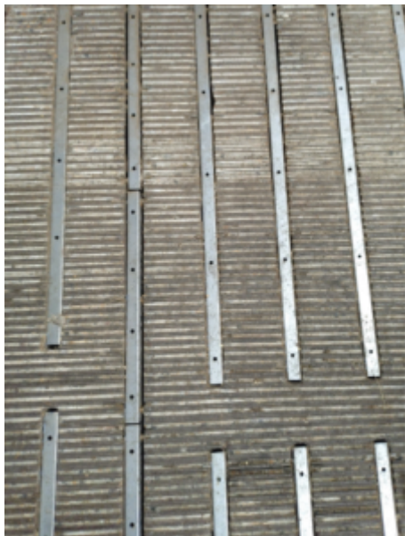
Afbeelding 1: Roostervloer voorzien van separatiestrips met urineafvoergaatjes in de roosterspleten (eigen beeldmateriaal).
