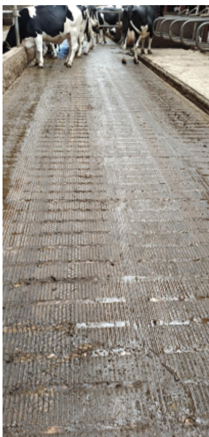
Afbeelding 4: Praktijkvoorbeeld van roostervloer voorzien van separatiestrips met urinevoergaatjes in de roosterspleten (eigen beeldmateriaal).
