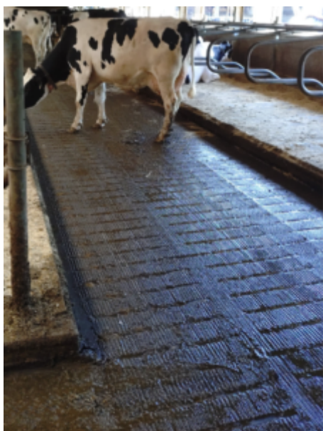
Afbeelding 2: Praktijkvoorbeeld van roostervloer voorzien van separatiestrips met urineafvoergaatjes in de roosterspleten (eigen beeldmateriaal).
